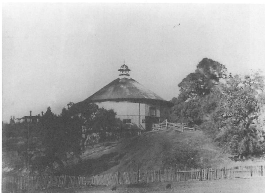
建設当時のラウンドバンの写真
