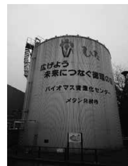
日田市バイオマス資源化センター (2006年4月運転開始。生ゴミ・畜産糞尿のメタン発酵による発電)
