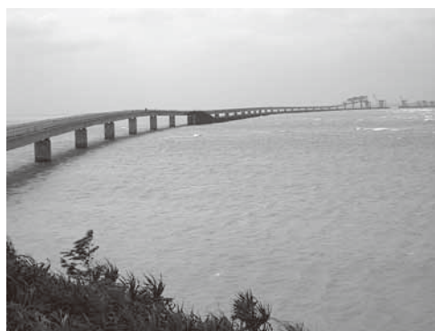
完成間近な伊良部大橋。宮古島から伊良部島への地下水送水管が添加される。
