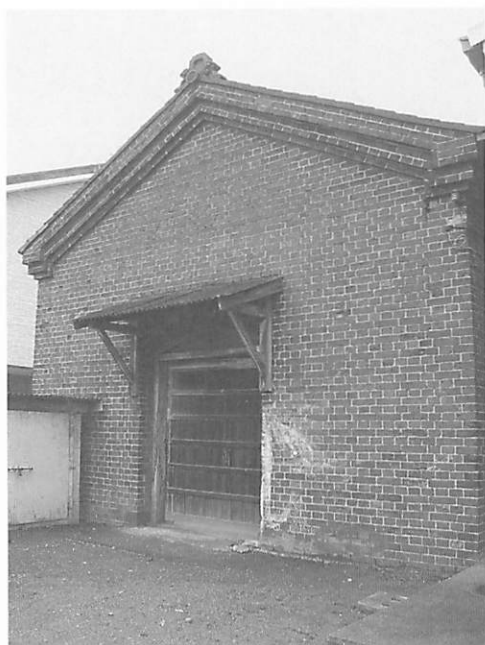
写真5 加茂駅ランプ小屋 2012年5月 筆者撮影
