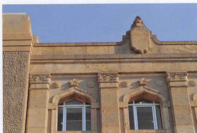
図 12 中央公民館の外壁に使われた加治木石 鹿児島市山下町
