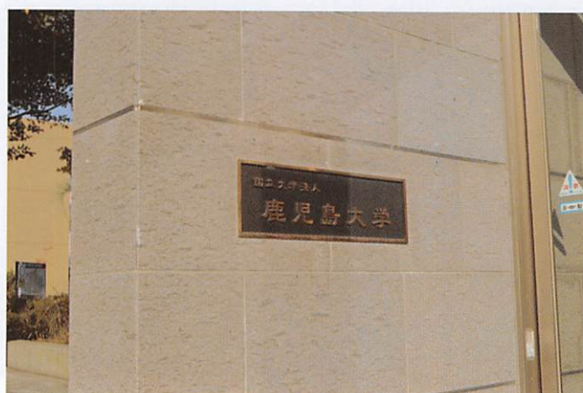
図 18 鹿児島大学インフォメーションセンターの 外壁に使われた「花棚石」 鹿児島市荒田
