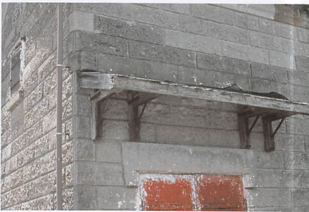
図 27 入戸火砕流の溶結凝灰岩を使った石倉 志布志市
